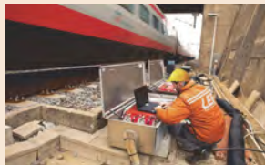
Installazione armadio di piazzale Un tecnico LEF durante l'installazione di un ADP su una linea AV per il riscaldamento elettrico deviatori
