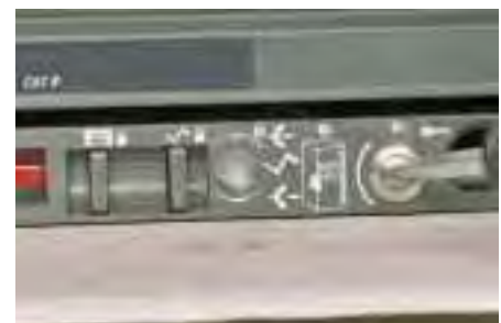
Racking Handle Shutter drive location - Verstellschraube für Schutzkappenantrieb - Posizione della vite dell'otturatore del meccanismo di manovra
