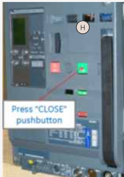
Abb. F: Zeigt den Versuch, die Handkurbelblende zu öffnen. Abb. G: Blockierter Sicherheitsriegel. Abb. H: Den "CLOSE"-Einschaltknauf betätigen um den Schalter einzuschalten (ON|EIN). Abb. I: "OFF"-Ausschaltknauf betätigen und den Schlüssel entnehmen.
