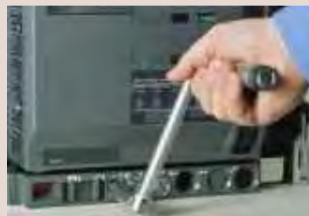
Fig. 1.12: Circuit Breaker in Maintenance Position Abb. 1.12: Leistungsschalter in Wartungsstellung Fig. 1.12: Interruttore in posizione di Manutenzione
