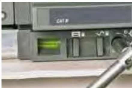
Racking drive in DISCONNECTED position - Einfahrstellungsanzeige in GETRENNT-Stellung - Meccanismo di manovra in posizione DISCONNECT
