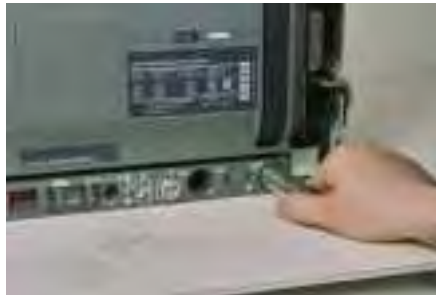
Racking Handle Storage Location - Einfahrkurbel Lagerungsort - Alloggiamento maniglia di manovra
