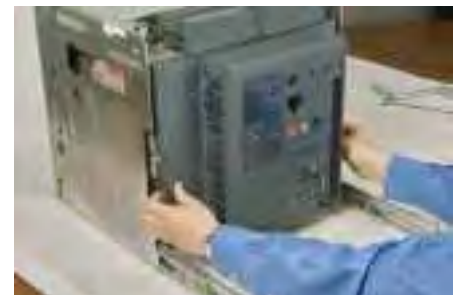
Pulling device from cassette for removal. - Schalter ausgezogen zur Entnahme - Tirare il dispositivo per rimuoverlo dalla parte fissa.
