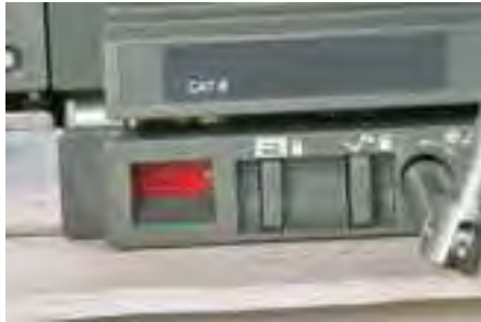
Racking drive in CONNECTED position - Einfahrstellungsanzeige in BETRIEBs-Stellung - Meccanismo di manovra in posizione CONNECT
