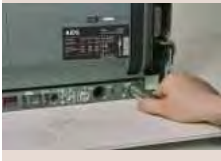
Fig. 1.9: Racking Handle Storage Location Abb. 1.9: Einschubeinfahrkurbel Lagerort Fig. 1.9: Alloggiamento maniglia di manovra
